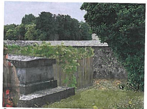
Conservation du sol actuel dans l'aire de déchets
